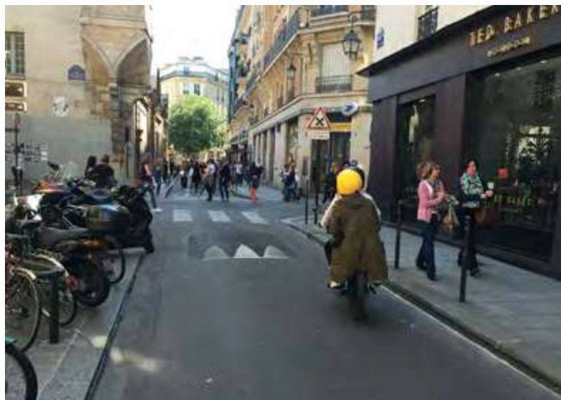
Figura 3.2 | Caso de almofada redutora de velocidade
